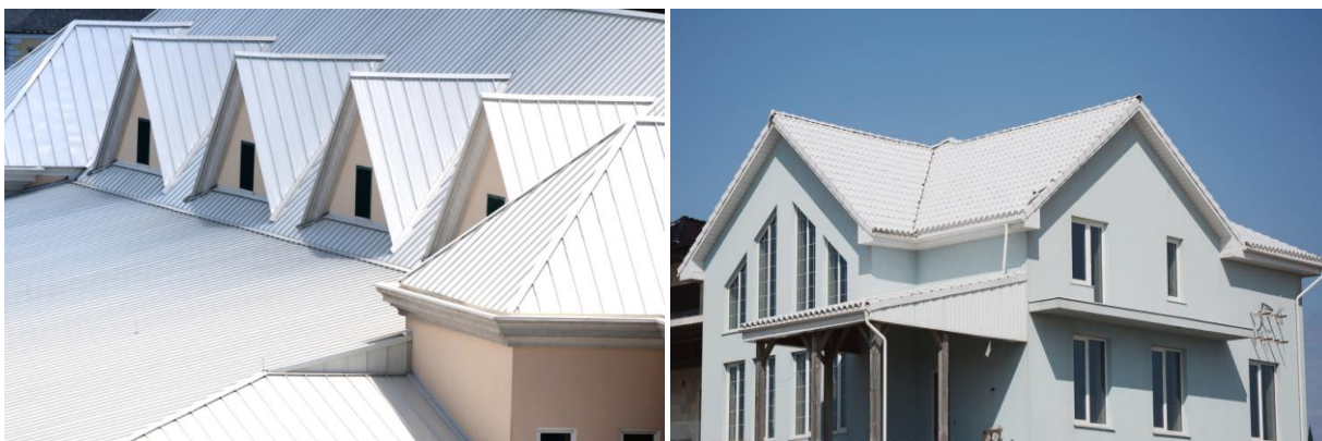
Esempi di applicazione di cool-roof su edifici esistenti [Fonti: in alto: https://newscenter.lbl.gov ; in basso a sinistra: https://ichi.pro ; in basso a destra: https://newscenter.lbl.gov ].
