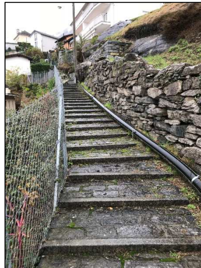
Fig.3: Condotta provvisoria volante.
