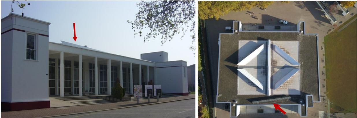
Il futuro impianto prevede di avere gli inverter posizionati nel locale tecnico sul tetto (angolo sud-est), a cui saranno raccordate le stringhe provenienti dai pannelli e la linea in uscita verso il quadro principale, tramite due linee di raccordo dimensionate per 100A.
