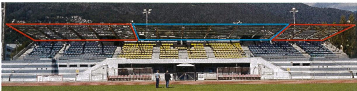
Schema della struttura. Parte centrale (1933) e parti laterali (1986).
