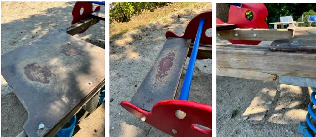
*Figure: Zone di intervento, risanamento con sostituzione delle sedute e lisciatura degli assi laterali*
