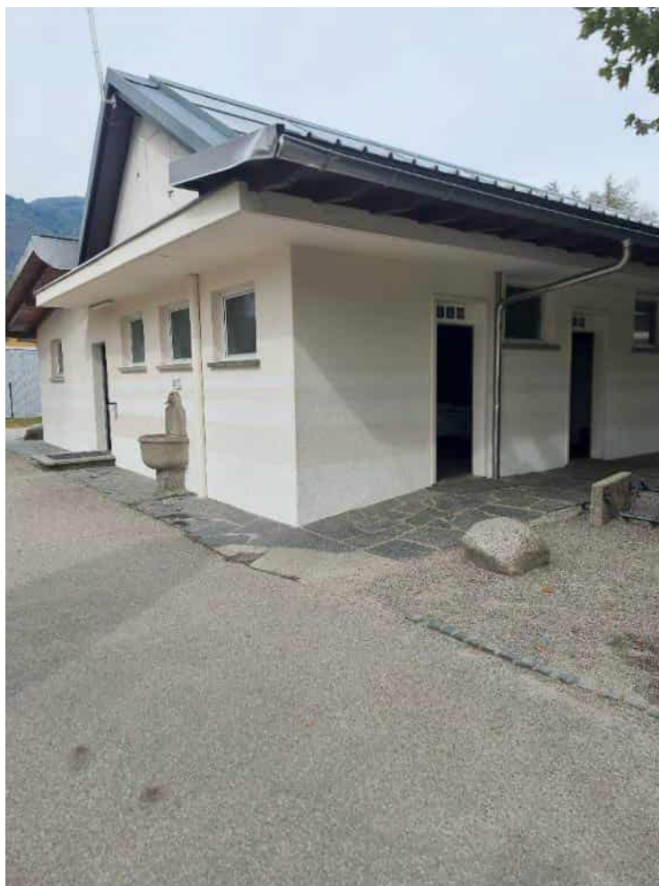
Figura 2.4.4: Vista stabile servizi igienici
