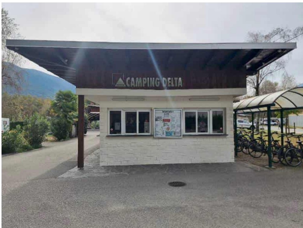
Figura 2.4.1: Vista stabile ricezione entrata
