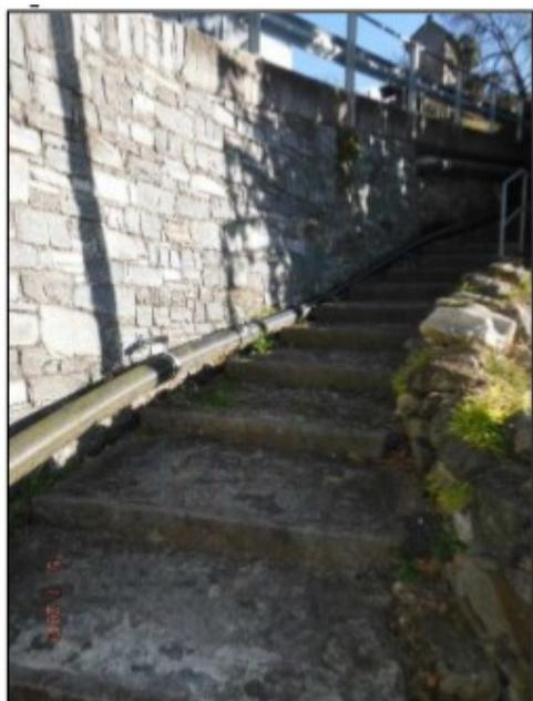
Fig.2: Condotta provvisoria volante.
