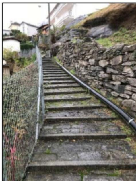
Fig.3: Condotta provvisoria volante.
