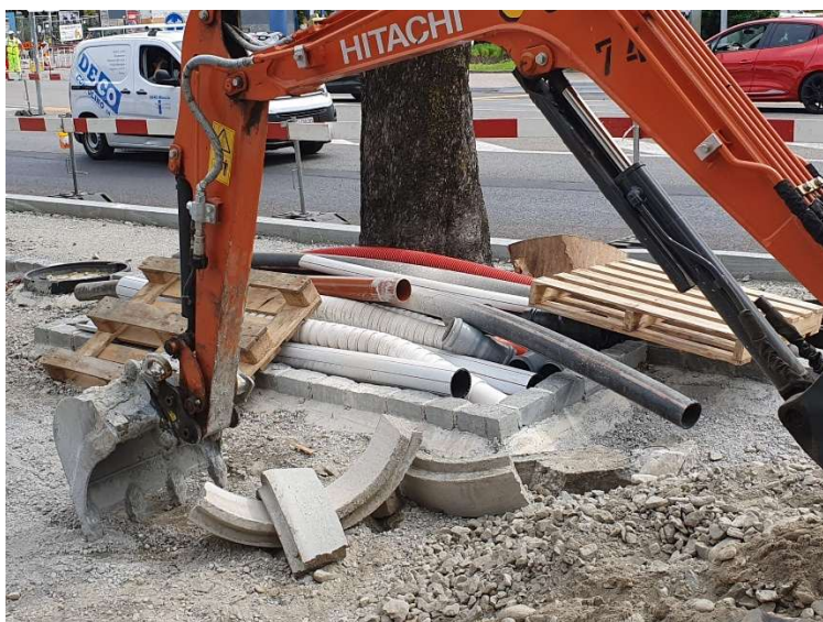
Foto 6: lavori per la nuova pensilina del Debarcadere.
