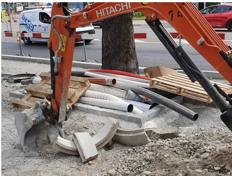
Foto 6: lavori per la nuova pensilina del Debarcadere.
